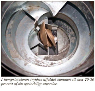
Med Roco-systemet folder affaldet ikke ned i en stor skraldebeholder, men en komprimator i bunden af skakten.
