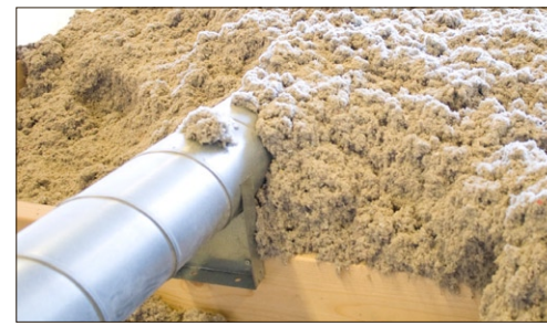
Mange bygninger er ikke ordentligt isoleret. Ved at få dem isoleret ordentligt, kan man både nedsætte forbruget af CO2 samtidig med, at man kan nedbringe udgifterne til opvarmning. Her er det papirisolering, der sørger for at holde loft og rør varme.
